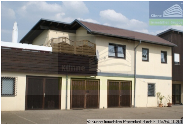
Hausansicht mit Sonnenterrasse
